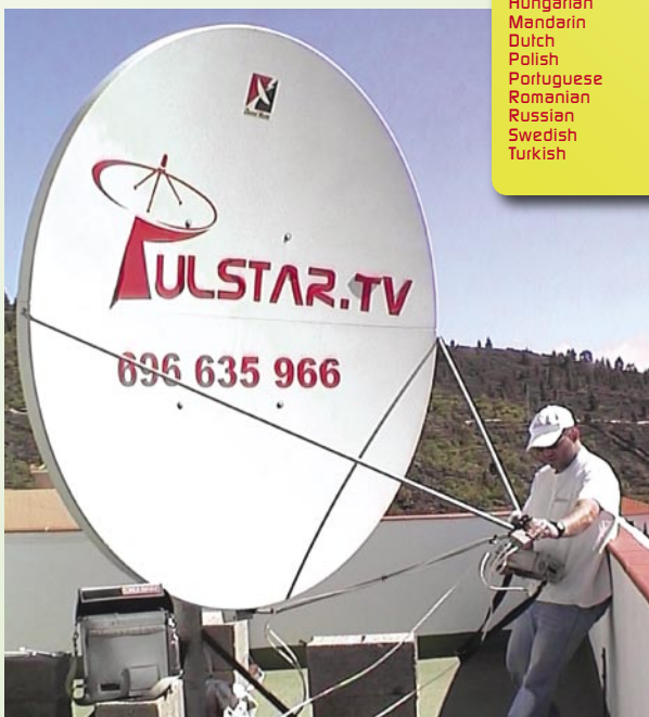
■ La petite élévation nécessaire pour recevoir les satellites américains frappe tout de suite. Car l'emplacement de Diego est assez haut dans les montagnes il peut assurer la réception même avec une si basse élévation.
