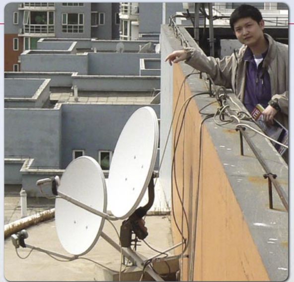
■ Le bricoleur de la réception satellite de Pékin. Des antennes additionnelles sont fixées sur une balustrade : une parabole de 75cm pointe vers 134°E avec une autre antenne de 60cm, motorisée par un moteur de MOTECK.
