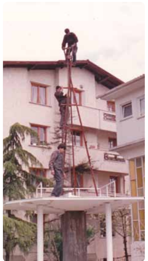
■ Mise en place des supports de soutien
